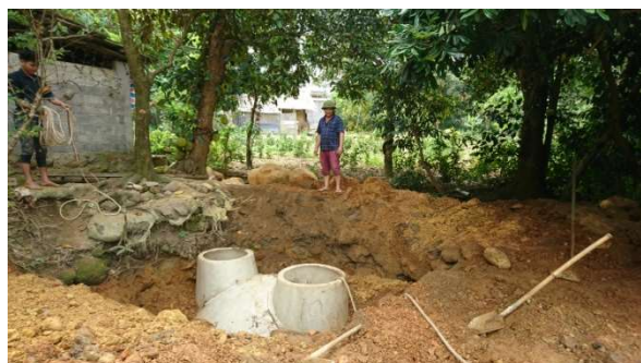
Ảnh 20. Giám sát lắp đặt hệ thống Biogas tại hộ Nguyễn Lương Phú (bản Ngọc Lại)
