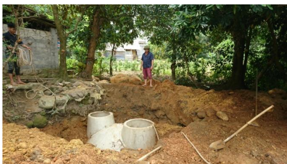
Ảnh 9: Lắp đặt hầm khí biogas
